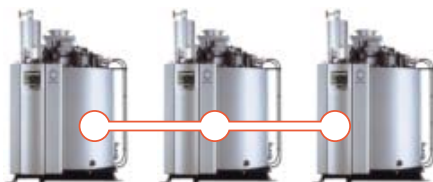
A vízmelegítő B vízmelegítő C vízmelegítő
